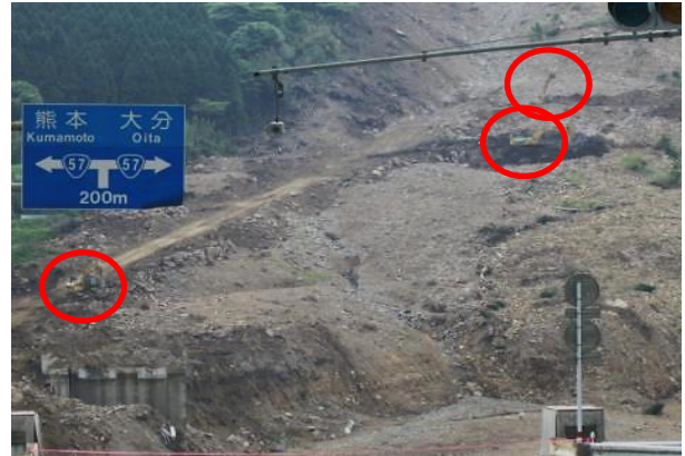
がけ崩れの現場では、無人ブルラシキ重機が
