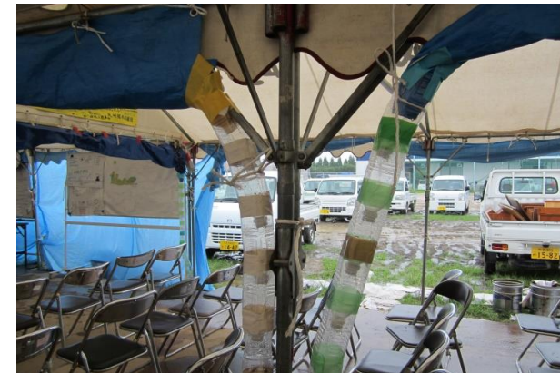
急ごしらえのテントの雨樋
